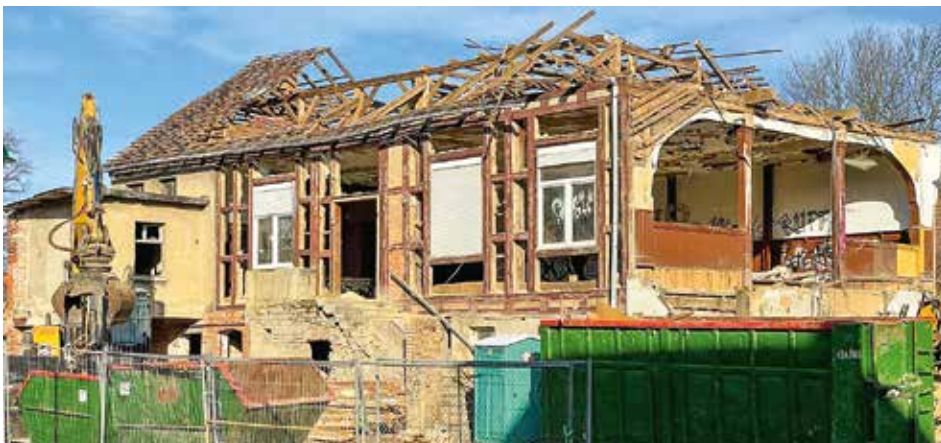
Die Abrissarbeiten am „Braunen Hirsch“ sind im vollem Gange, nur vom ehemaligen Saal ist noch etwas zu sehen. Foto: © Gemeinde Nordharz
