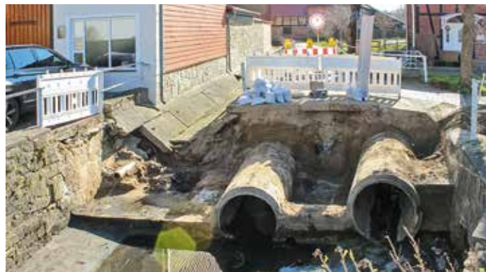
Begonnen haben die Arbeiten in der Büchenstraße bereits.
