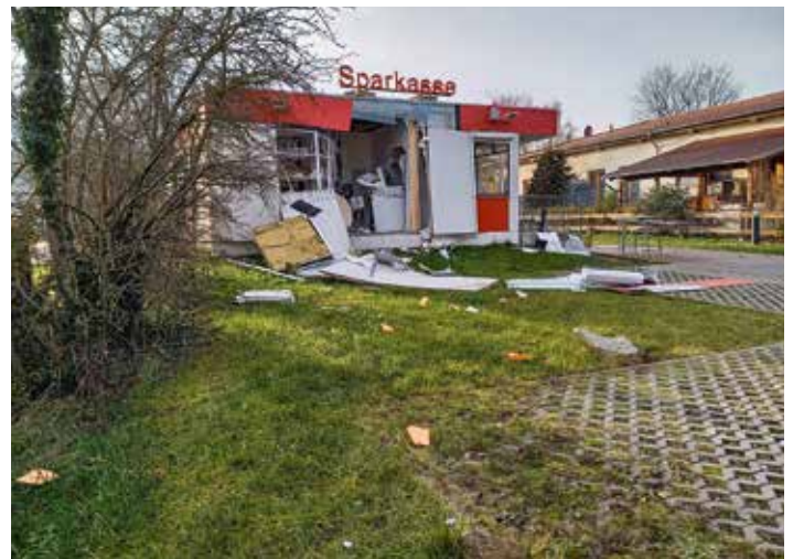
Stark zerstört ist der Sparkassencontainer durch die Sprengung des Geldautomaten. Foto: © Jörg Niemann
