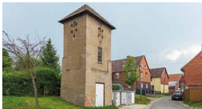
der ehemalige Trafoturm
