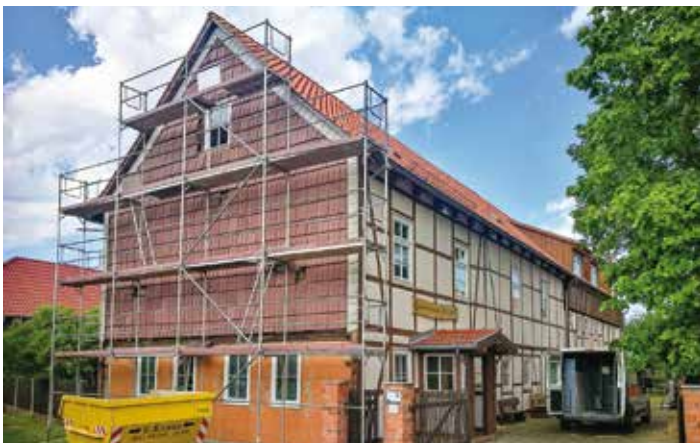
Der Westgiebel ist eingerüstet und bereit für den neuen Wandbehang und Wärmeisolierung Fotos: ©Jörg Niemann
