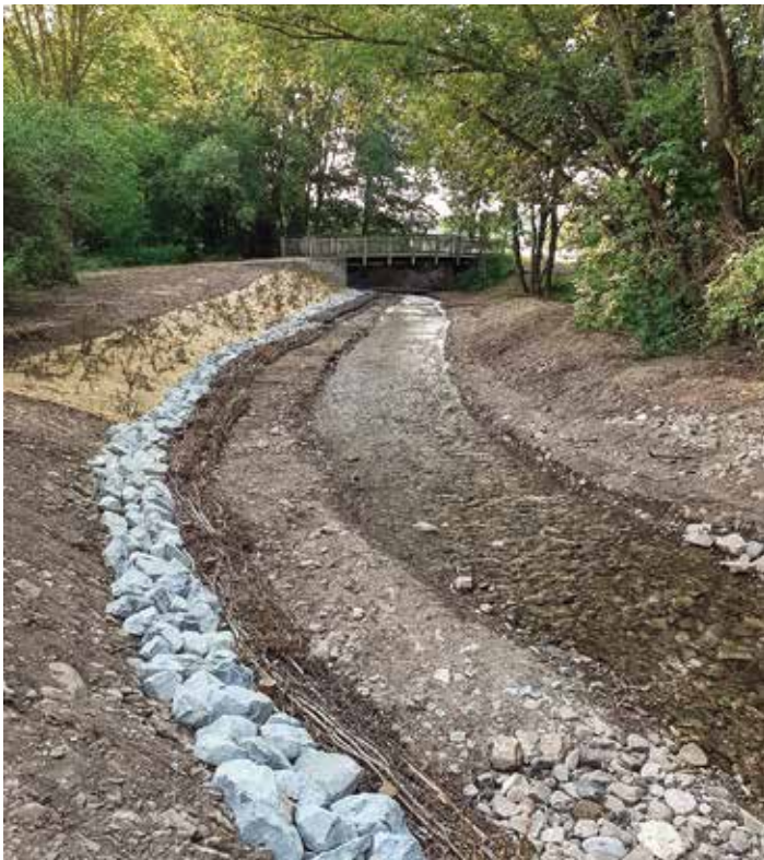
Nach der Sanierung im vergangenen Juni ist der Zustand des Ufers wieder so hergestellt, wie er vor dem Hochwasser 2017 gewesen ist. Fotos: © Wolfgang Mertins
