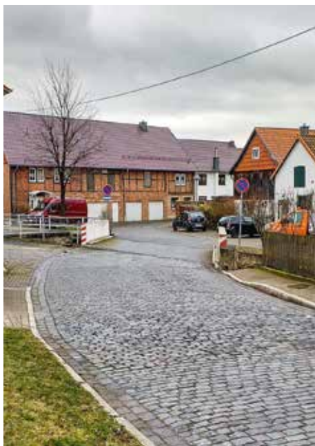
So sieht der Bereich um die Wasche und die Sandfurter Straße vor dem Sanierungsbeginn aus. Foto: © Sven Ebeling
