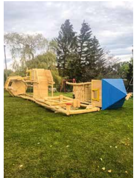
Die Holzkonstruktion im Aufbau.
